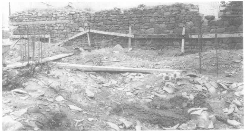
Fig. 7 : Restes de fours exhumés par un chantier moderne
