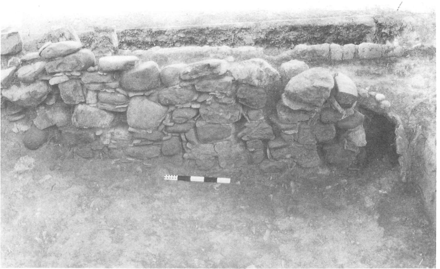
Fig. 4 : Mur de soutènement en pierre.
