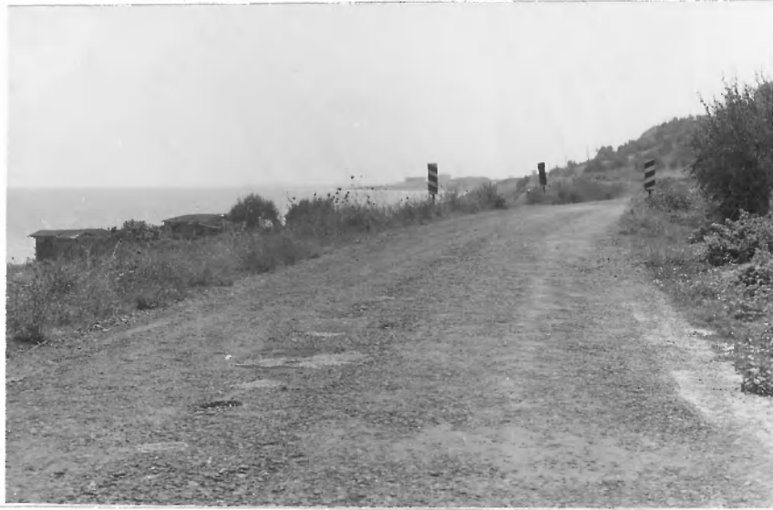
Fig. 20 - La route actuelle sur la côte à Gaziköy.
